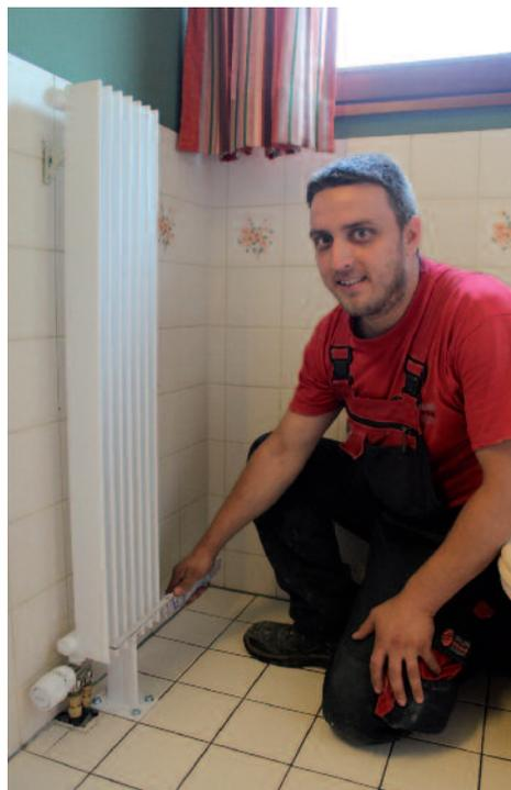
Ein Mitarbeiter der Omlin Energiesysteme AG prüft die Dimension der Heizkörper. Jeder Radiator wird individuell geplant und auf Mass angefertigt.
