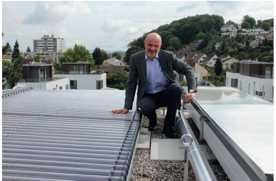
Martin Omlin posiert mit den modernen Röhrenkollektoren und den Abkühlungsheizkörpern auf dem Dach.
