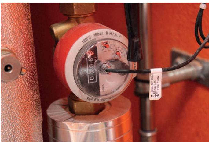
Die Zähler für den Solarertrag (links) und für die Wärmepumpe zeigen jederzeit, wie effizient die Anlage arbeitet.
