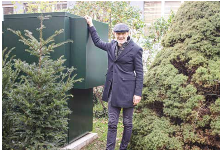
Martin Omlin mit der Monoblock-Wärmepumpe im Hinterhof der Schwarzwaldallee.
